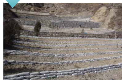
技プロによる治山工事の実施
