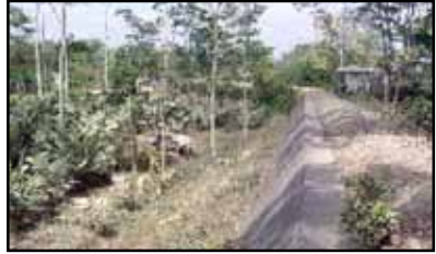
TANGGUL TANAH DIPERKUAT DENGAN PASANGAN BATU
