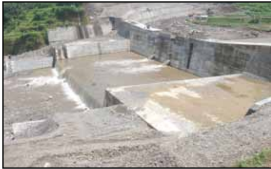
BANGUNAN SABO DAM
