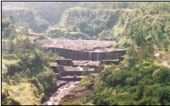
BANGUNAN SABO UNTUK PENGENDALIAN LAHAR
