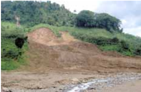
SALAH SATU BENTUK TANAH LONGSOR DI SUATU LOKASI/TEBING SUNGAI DINOYO KABUPATEN JEMBER AKIBAT BANJIR BANDANG 2 JANUARI 2006
