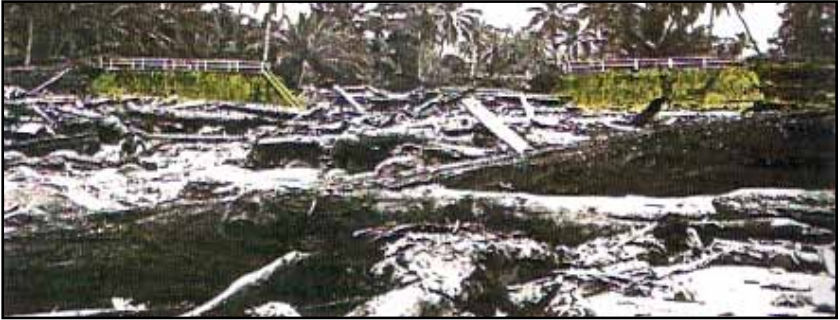
MATERIAL DEBRIS DI HULU BPS BATANG LOLO I
