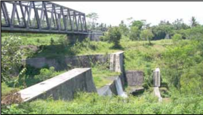
DAM KONSOLIDASI UNTUK PENGAMANAN DAN IRIGASI
