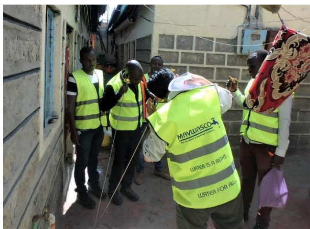
音聴棒を利用した給水管の漏水探知作業
