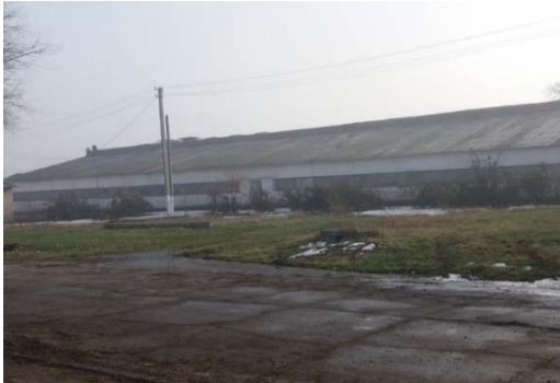
写真 1：現有の搾乳牛舎の全景
