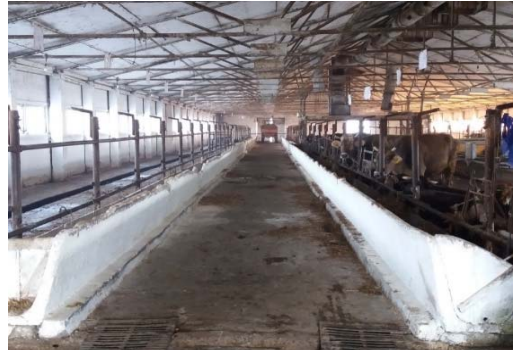
写真 2：現有の搾乳牛舎の内部
