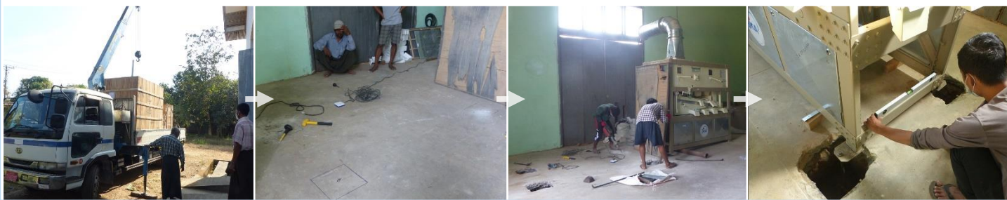
写真（左から）・トラックでの機材搬入、・位置決めとマーキング、・土台の基礎工事、・機材を固定して水平を測定
