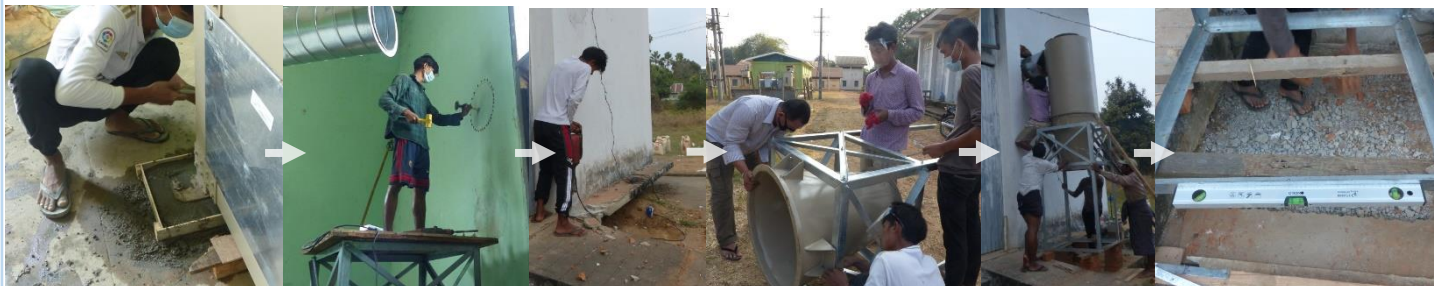
続き（左から）・アンカーボルトの埋め込み、・ダスト排出口の穴開け、・サイクロン土台の基礎工事、・組み立て
