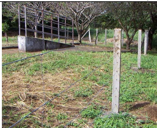
Poste de cemento
