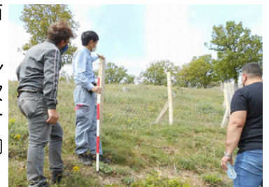
防護フェンス設置状況の確認
