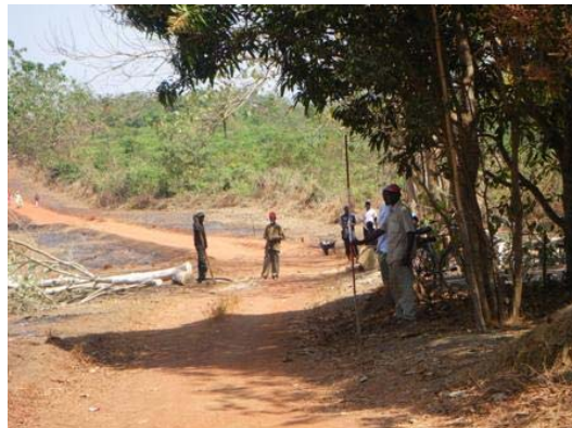
業者による測量。工事の一番初めの作業で村人も雇用される。
