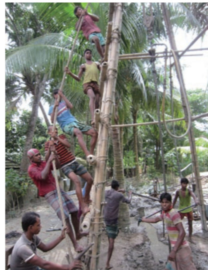
深井戸であれば、砒素が混じることはない。人力で深さ200メートルの井戸を掘る
