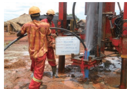
モザンビークで建設したハンドポンプ付深井戸の洗浄
