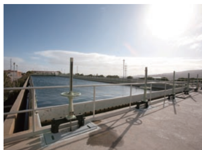
ヨルダンの首都アンマンに給水するザイ浄水場
