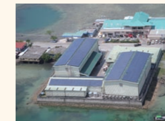
パラオの商業施設に取り付けられた小規模太陽光発電システム。JCMクレジットが発行された(写真提供:環境省)
