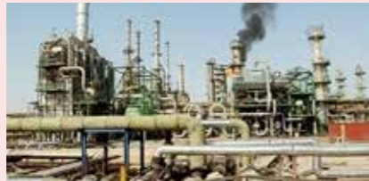
1970年代に日本企業が建設したバスラ製油所。建設工事は来年前半から。2025年に完成予定だ。
