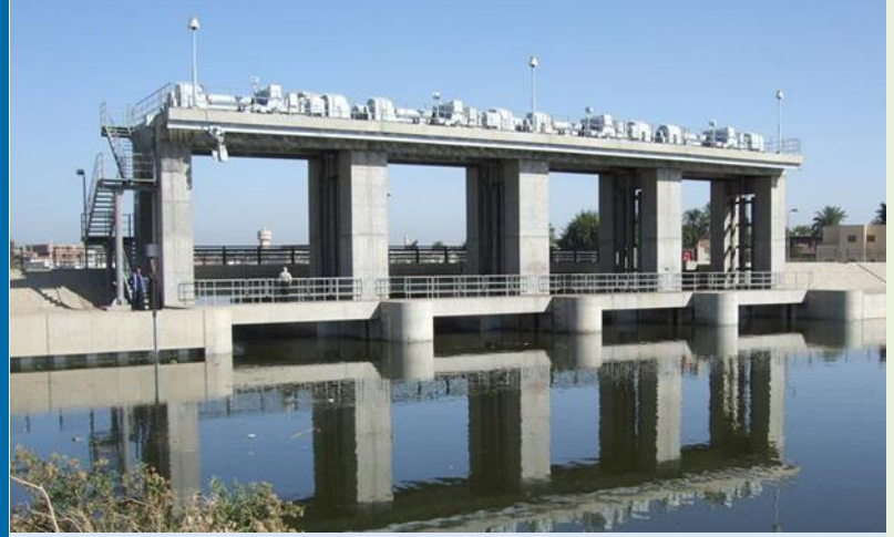
قناطر منشأة الذهب على ترعة بحر يوسف (منحة لإعادة تأهيل القناطر - ٢٠١٠)
