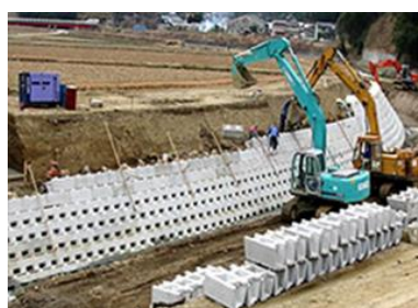
提案製品の施工事例
