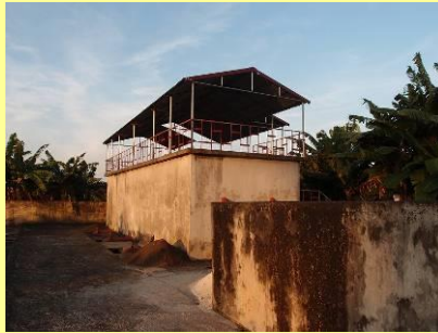
Trạm bơm nước được quản lý phù hợp thông qua Dự án
