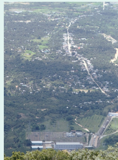
Da Nhim Dam
