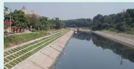
ハノイ市のトゥー・リック川河川改修後
