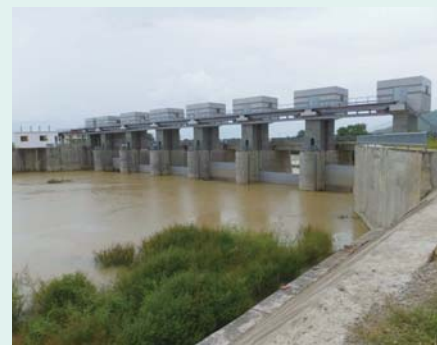
ファンリーファンティエツト灌漑水路の最上流に建設された頭首工
