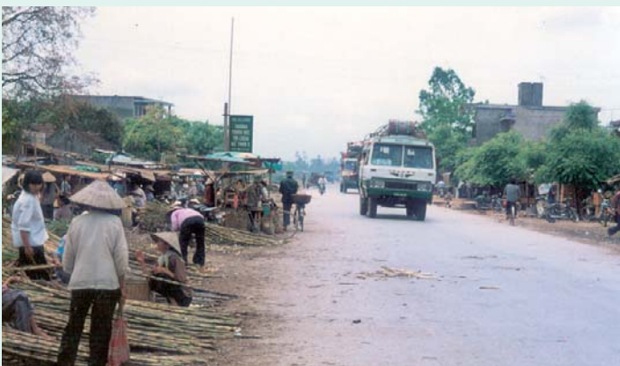
復旧前の国道5号線
