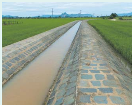
ファンラン灌漑事業によって建設された水路の一部。50年経った今も大地を潤す
