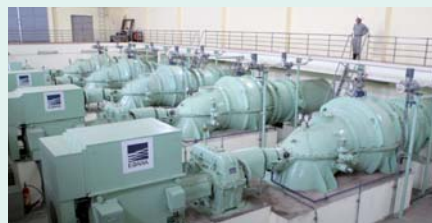
イェンソー・ポンプ場
