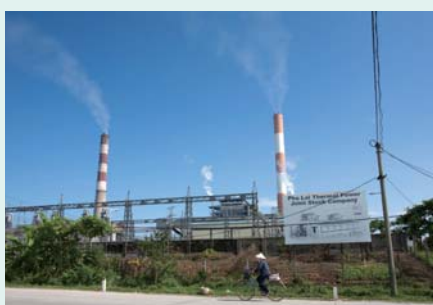
ファーライ火力発電所
