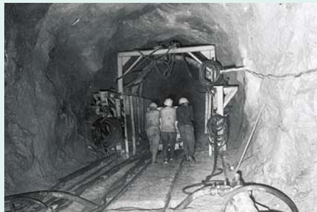
圧力トンネルの掘削の様子
