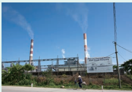
Nhà máy nhiệt điện Phả Lại
