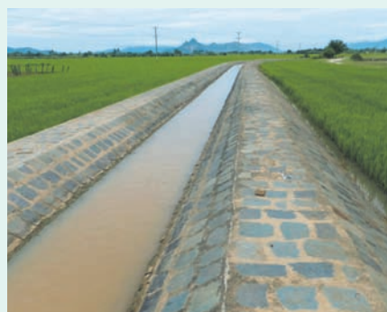
Một phần của hệ thống kênh được xây dựng trong công trình thủy lợi Phan Rang. Trải qua 50 năm, đến nay kênh vẫn tiếp tục đưa nước đến với đồng ruộng
