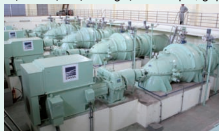
Trạm bơm Yên Sở
