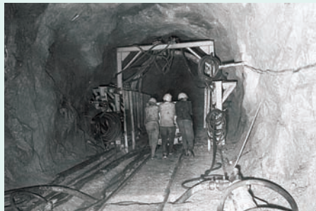
Quang cảnh khoan đường hầm áp lực
