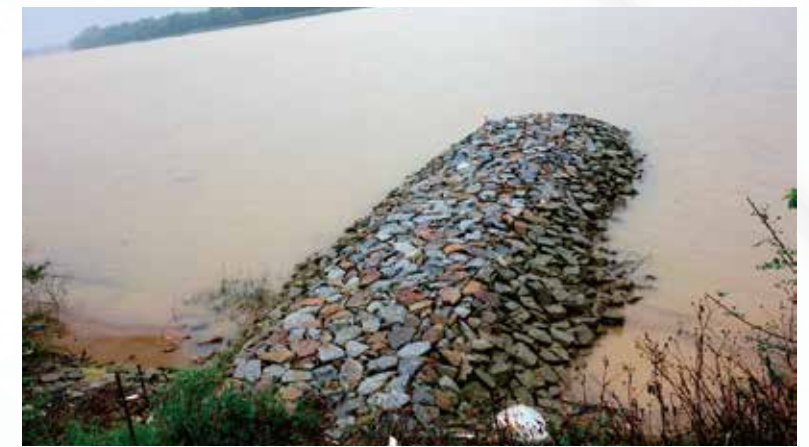
河岸保護対策工事(クアンビン省 トーリン村ラオナン川流域)
