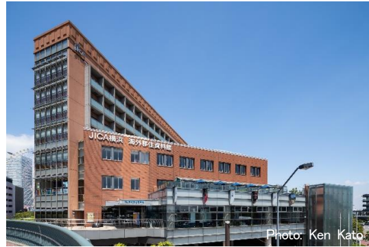
JICA 横浜 建物外観
