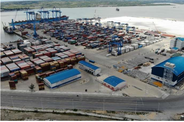
東アフリカ最大の国際貿易港であるモンバサ港(ケニア)。港開発、及び港周辺の道路開発を実施。 [写真提供: 東洋建設株式会社]
