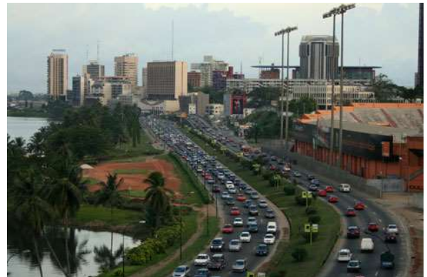
アビジャン市(コートジボワール)の渋滞の様子。技術協力「大アビジャン圏都市整備計画策定プロジェクト」にて持続可能な都市計画を支援。
