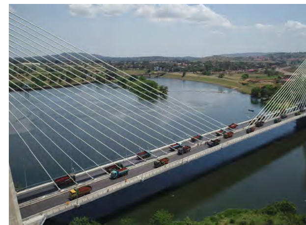
日本が協力し建設された北部回廊に架かるナイル川源流橋 (ウガンダ)
