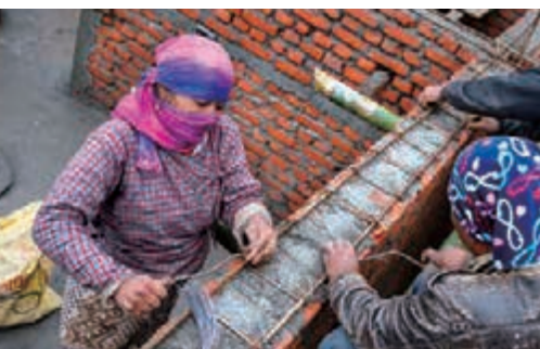
2015年に発生したネパール地震。JICAは被災した住宅に対して、耐震住宅の再建に協力（ネパール）
