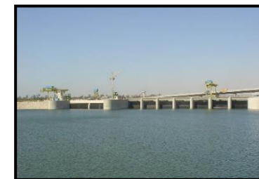
Naga Hamadi Barrage
