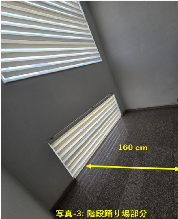
写真-3: 階段踊り場部分
