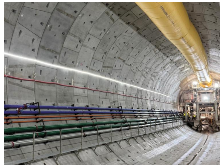
パナマで建設が進む地下鉄のシールドトンネル掘削現場
