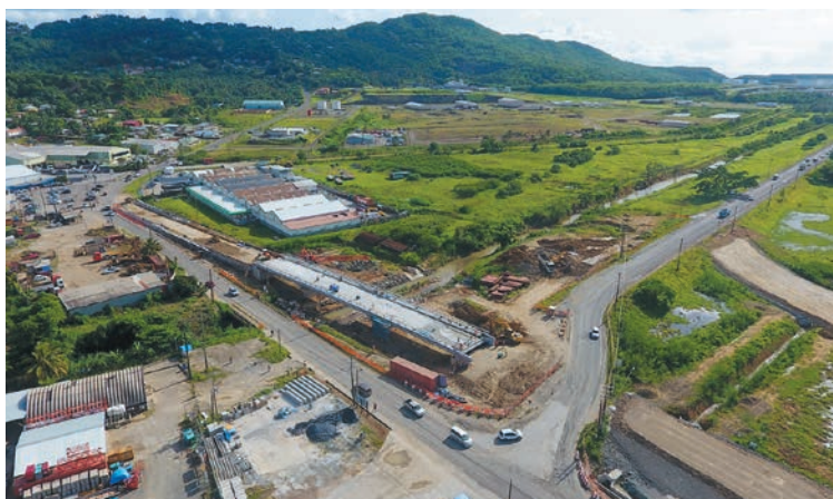
セントルシア：同国では自然災害が多く、災害時の避難や復興を支える交通インフラの整備が喫緊の課題。JICAは首都と国際空港を結ぶカルデサック橋の架け替えに協力している
