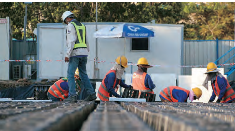
技術の普及を図るため施工は現地建設会社に依頼。プラスチック素材で軽量なため、運搬や組み立て作業が楽なことも製品の大きな魅力となっている
