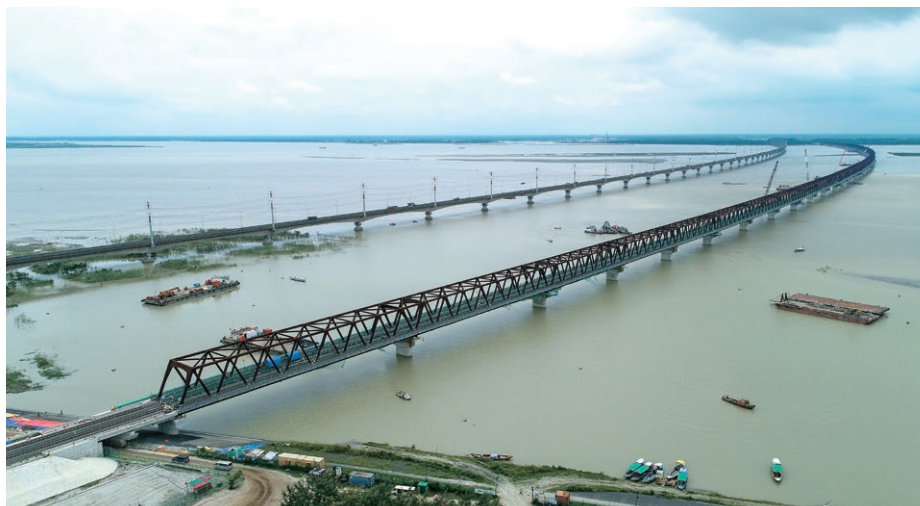
2025年3月に開通したバングラデシュ最長の鉄道橋「ジャムナ鉄道専用橋」 [写真:大林組・東亜建設工業・JFEエンジニアリング共同企業体]
