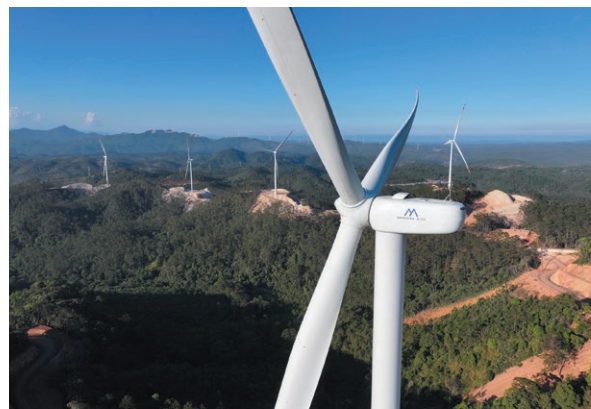
ラオスの山岳地帯に建設された風力発電設備 [写真: Monsoon Wind Power Co., Ltd.]
