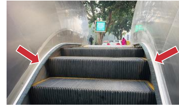
駅のエスカレーターには、インドの女性が着る裾の長いサリーが巻き込まれることを防ぐブラシ「サリーガード」が付けられている
