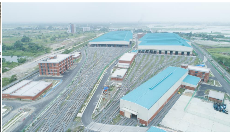
車両基地(写真: 日本工営)
