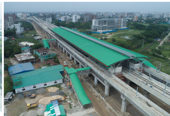
始発駅(ウットラ北駅)の駅舎(写真: 日本工営)
