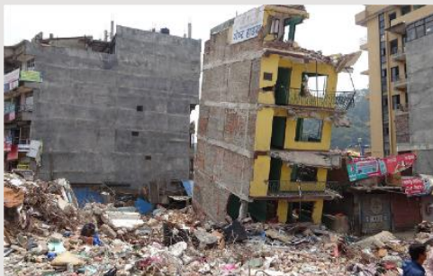
2015年ネパール地震災害の被災状況
