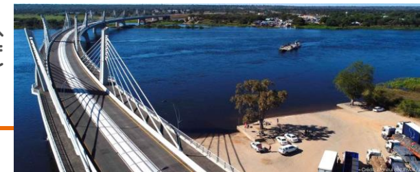
ボツワナ・ザンビア国境のザンベジ川に新設されたカズングラ橋
