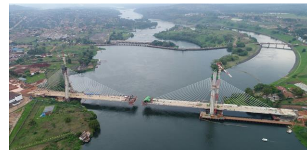
ウガンダ「ナイル架橋建設事業」(建設中写真)
