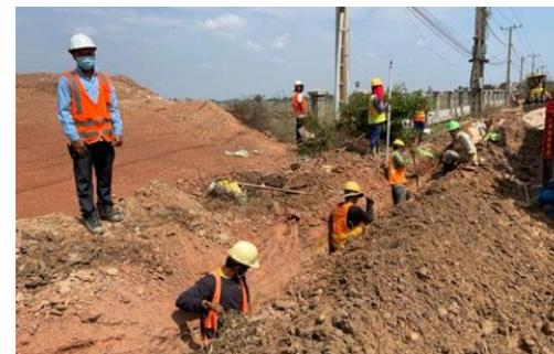
水道管敷設ルートを手掘り作業する様子
