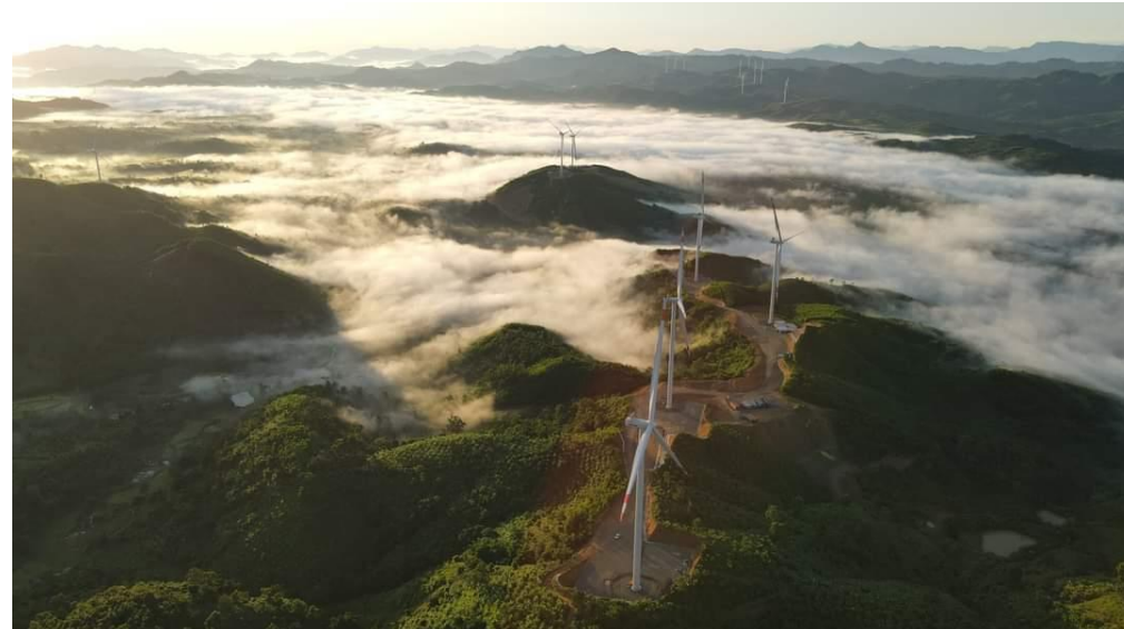
融資先のプロジェクトカンパニーにより建設された風力発電設備（写真提供：レノバ社）
