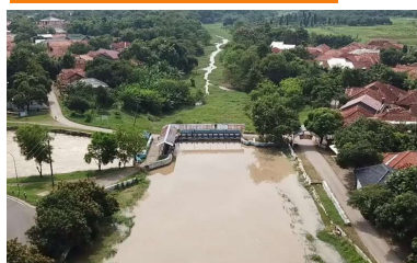
近代化工事前
