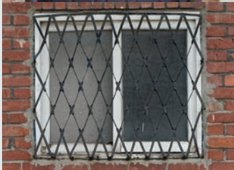
第二次防衛線の窓
