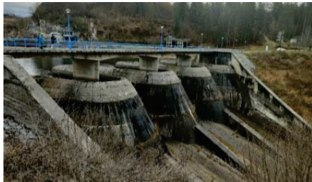
① ラドイニャダム堤体 (クラクダム貯水池上流端)
