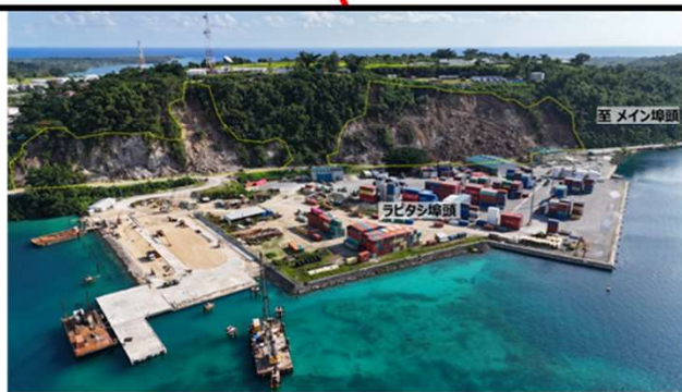
ラペタシ国際多目的埠頭横の斜面崩壊
