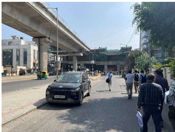
(3-1) JP Nagar 4th Phase駅 建設予定地
