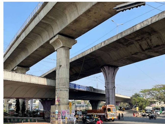
(3-1) Mysore Road駅 建設予定地周辺（既設メトロ口と交差）
