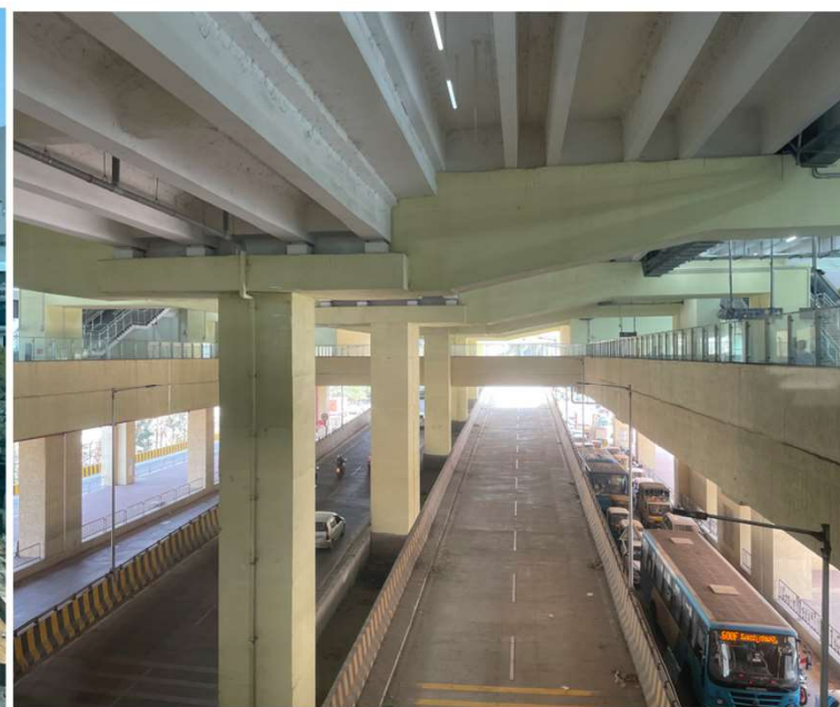
ダブルデッキ高架橋 Ragigudda駅 メトロ高架下
