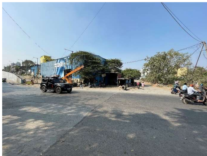
(3-1) Mysore Road駅 建設予定地
