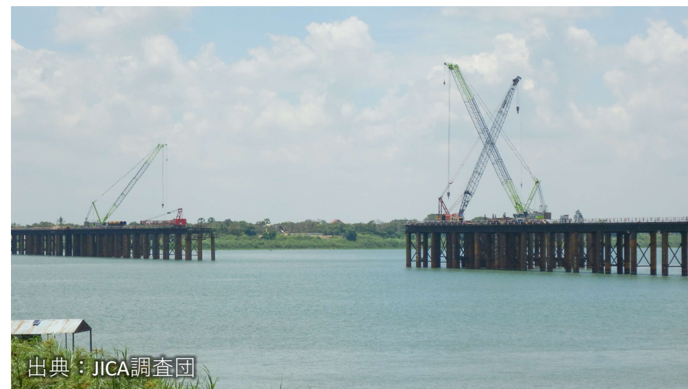
建設中の環状3号線メコン架橋
