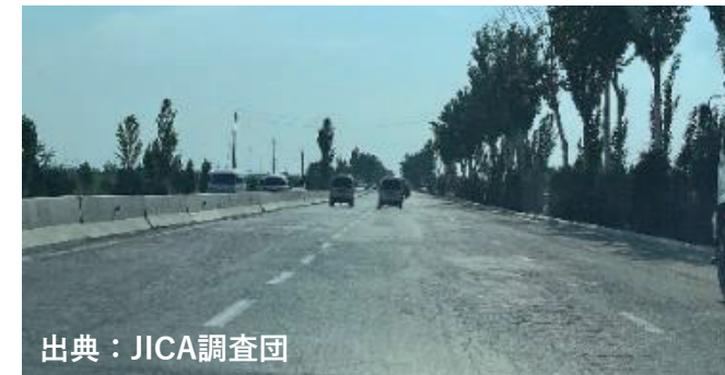
《アスファルト舗装状態（20km地点）》
