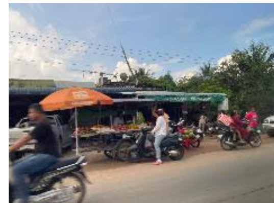
KT&TL地区の幹線水路上に建設された建築物の事例
