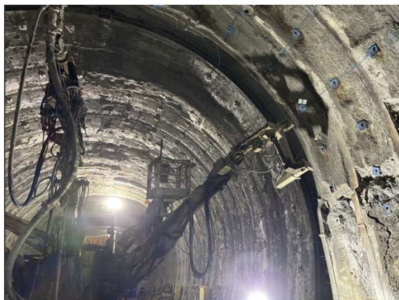
トンネル坑内の作業風景
