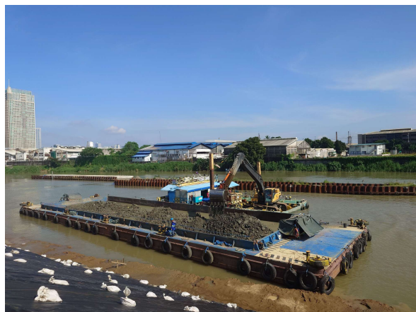
バックホウ浚渫船による 土砂等の除去作業
