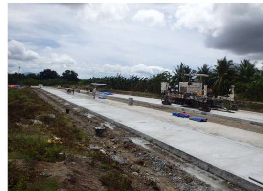
Malagamot Rd Junctionの現場風景
