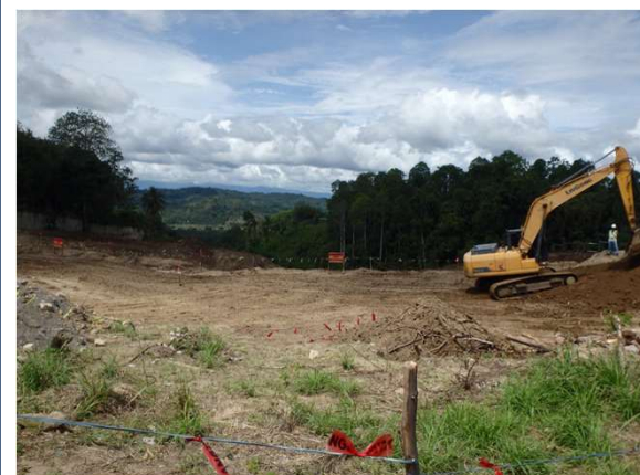
CCT(開削トンネル)現場風景
