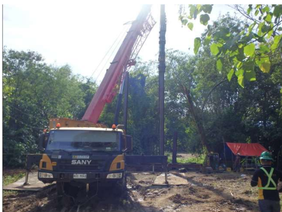
Creek5アクセス道路の現場風景
