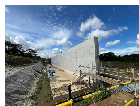
逆T型高水堤防壁
