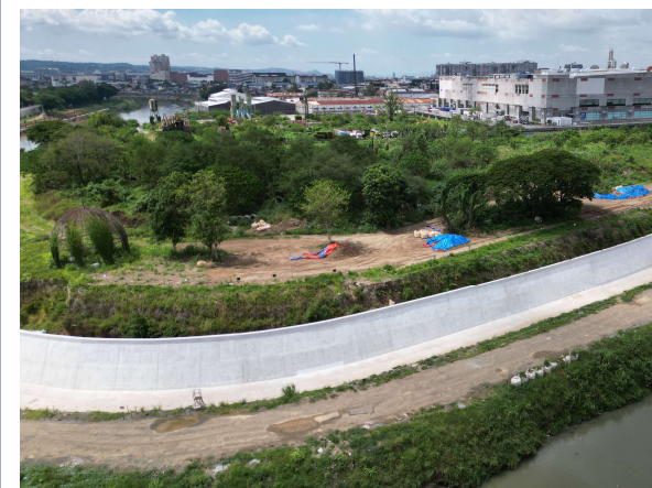
もたれ擁壁型高水堤防壁
