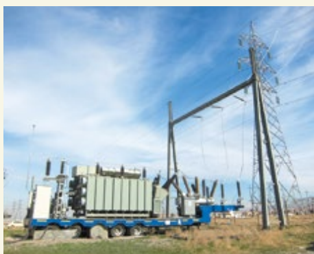
移動式発電所
