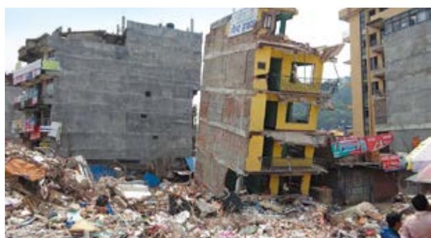
ネパール：2015年4月の大地震により倒壊した建物
