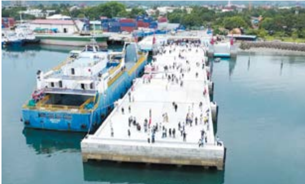
東ティモール：国内唯一の国際港湾として機能するディリ港。既存のフェリーターミナルを無償資金協力により移設・拡張し、旅客と貨物の分離を促進。2019年10月に竣工を迎え、東ティモールにおける安全かつ効率的な海上輸送の拡大に貢献している
