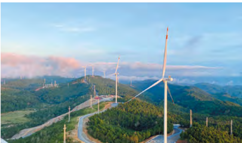
ベトナム：アジア開発銀行、豪州輸出金融公社と協調して、海外投融資により資金協力を行っている、クアンチ省陸上風力発電事業。出資者は、日本の再生可能エネルギー発電事業者である株式会社レノバと地場の電気事業者であるPC1 Group Joint Stock Company。2021年10月に完工、発電を開始した[写真：株式会社レノバ]
