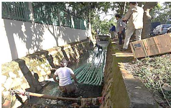
「中小企業海外展開支援事業～案件化調査～」で契約を締結したティービーアール(株)がインドネシア・ジャカルタ特別州の河川浄化に役立てるための実証試験を開始します。同社は微生物が繁殖しやすいロープを開発。河川に設置するだけで微生物が汚染物質を分解・除去します。低コストで短期間での設置が可能となり、問題解決に向けた第一歩としての普及が期待されます。
